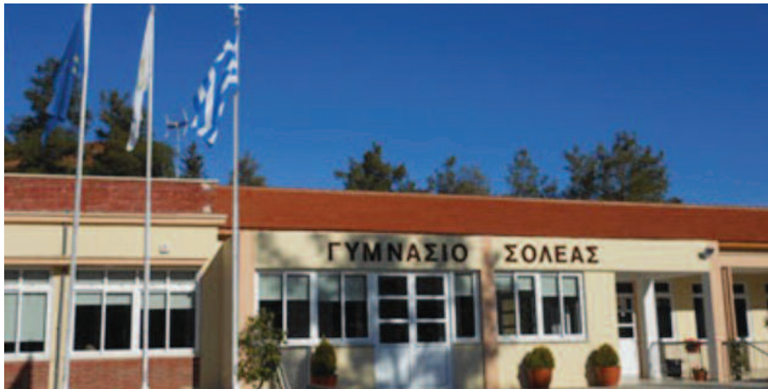
Εικ. 44: Το κτίριο του Γυμνασίου Σολέας στην Ευρύχου.
